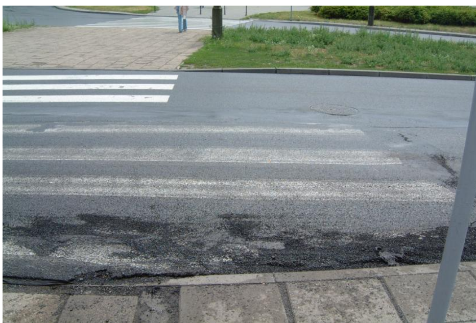
Rysunek 2.34 Widok całkowitego poślizgu warstwy na skutek braku szczepności międzywarstwowej (fot. P. Jaskuła)
