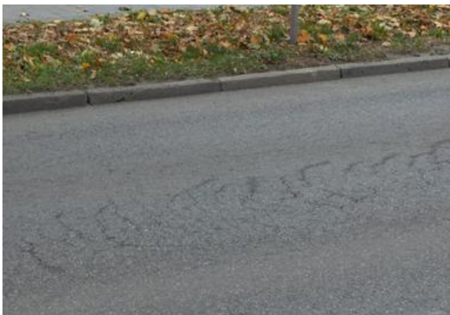
Rysunek 2.33 Widok księżycowatych spękań na skutek braku szczepności międzywarstwowej (fot. P. Jaskuła)
